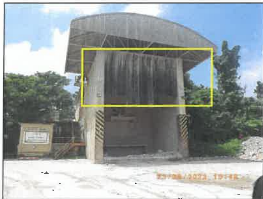
รูปที่ 2-15 ม่านริวและระบบสเปรย์น้ำบริเวณโรงโม่
